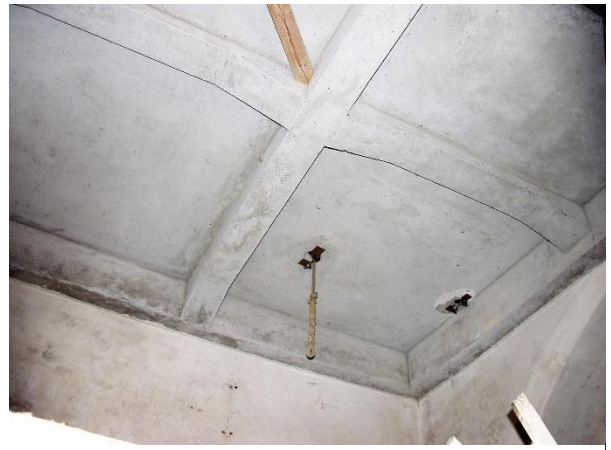
293. Betonnen verdiepingsvloer gezien vanaf de begane grond.
