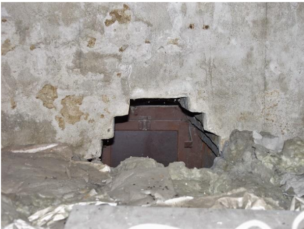
292. Getrapt venster begane grond noordzijde.
