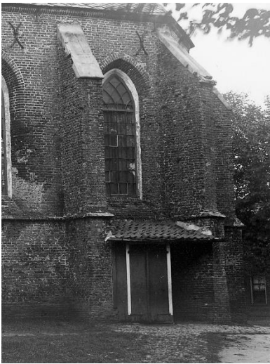
91 - 93. De koorentree voor en na de brand, en tegenwoordig. De rechter steunbeer was hersteld in een kleinere baksteen. Daar is nu niets meer van te zien.
