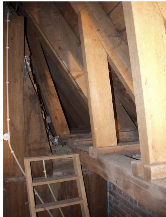
227. Kapvoet met gespannen, voorzien van een standzoon en blokkeel, opgelegd op de binnenste muurplaat.
