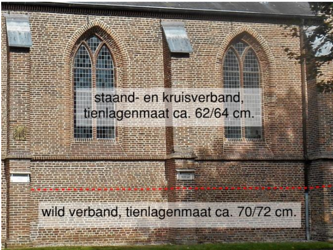
69. Het verschil in metselwerk onder en boven ca. 1.60 meter is ook aan de zuidgevel consequent aanwezig.
