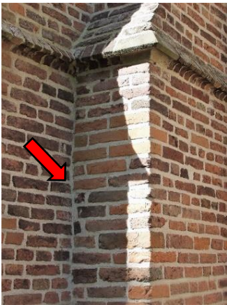
85 - 86. De steunbeer van het schip is duidelijk 'koud' tegen de steunbeer van het koor aangezet.
