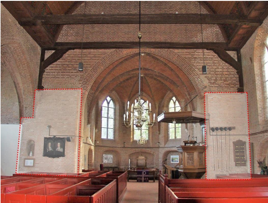
173. Triomfboog met ter weerszijde 'klampmuren' (omkaderd).
