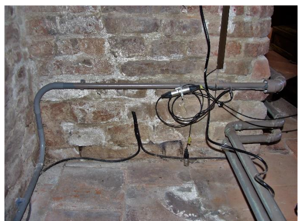
190 - 195. De onderste lagen metselwerk van het koor en triomfboog bestaan uit kloostermoppen met formaten van ca. 30/32 x 14/15 x 7/8,5 cm. De nissen zijn opgehoogd met kleinere stenen.
