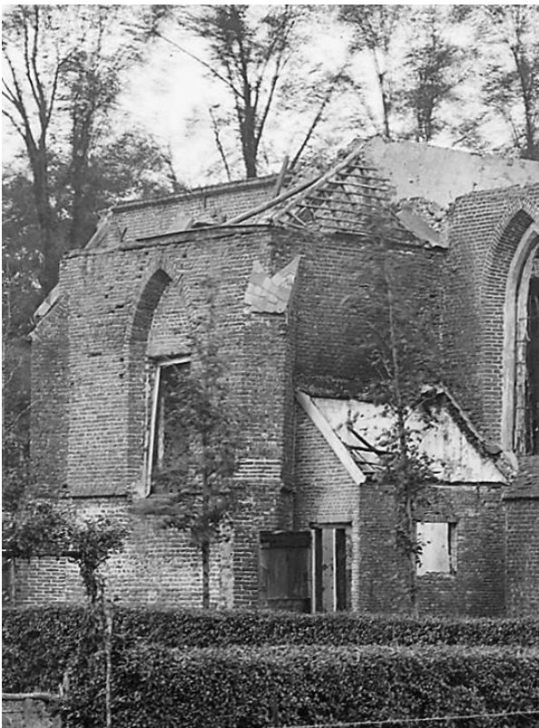
115. De kapel na de grote brand. Het spitsboogvenster had een rechthoekig raam, met daarboven een gemetseld boogveld. Tegen de westgevel was een voorportaalje opgetrokken dat direct toegang gaf tot de kapel.
