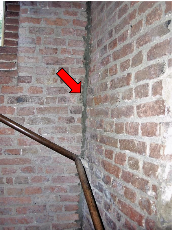
158 De afwezigheid van een metselverband laat zien dat de gevel van het schip later tegen de toren is gebouwd.
