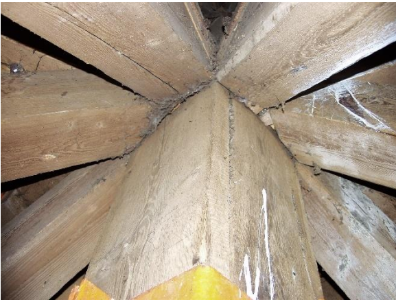
323. Stervormig tafelment tweede stage.
