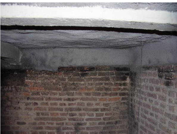
299. Roetsporen van de grote brand bij de verjonging onder de verdiepingvloer.
