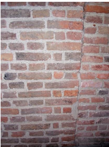
151. Klezortjes (kwart bakstenen) in het hoekverband van de toren. De gevel van het schip staat er 'koud' tegenaan.
