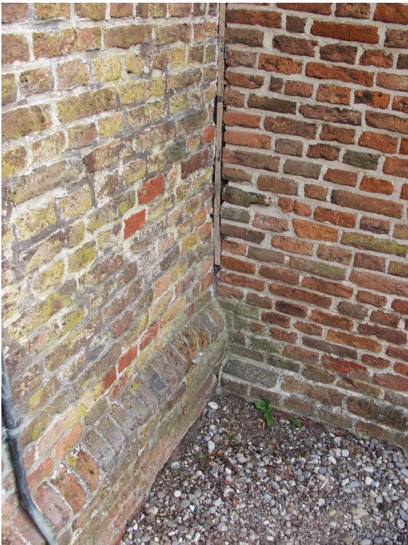
56. De westgevel (rechts) is koud tegen de toren geplaatst.
