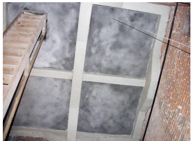
313. Betonnen verdiepingvloer gezien vanaf de tweede verdieping.
