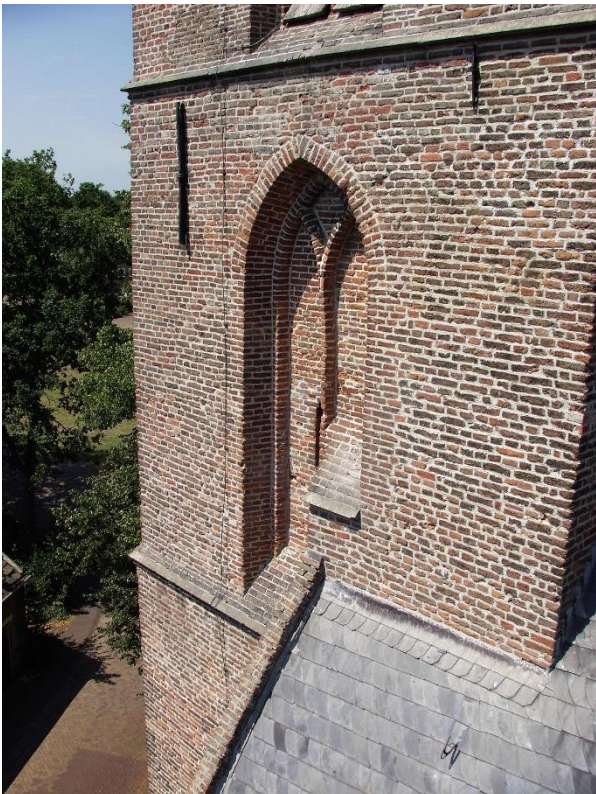
261 - 262. Tweede geleding zuidgevel. De vlakken van het blinde venster waren in 1889 nog gestuukt. Let op de resten van pleisterwerk onder de afzaat
