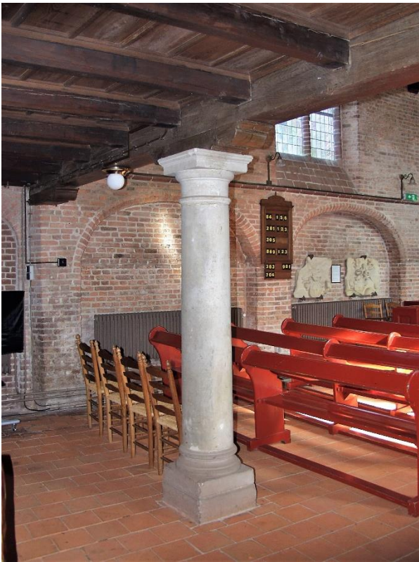
147. De orgeltribune wordt ondersteund door twee Toscaanse zuilen van natuursteen. Op de moerbalk zijn kinderbalken opgelegd.
