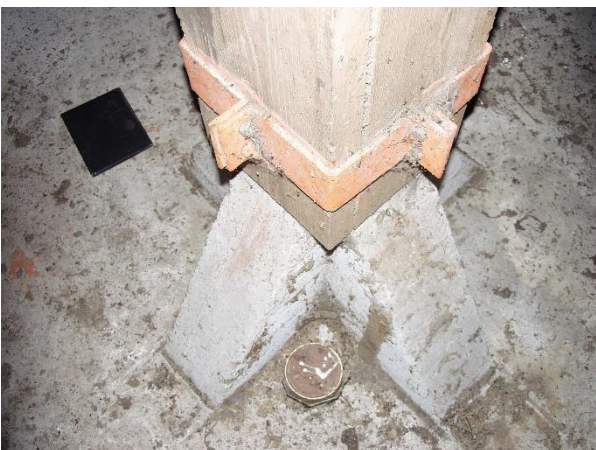
319. Betonnen basement makelaar.
