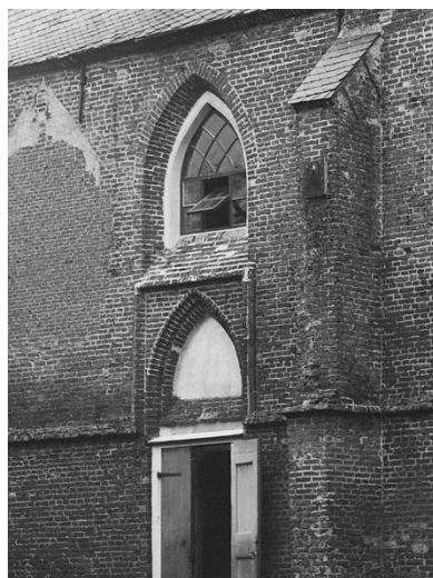
61 – 62. De voormalige herenentree werd na de brand zeer sterk gerestaureerd. De naar buiten openslaande deuren maakten plaats voor een zware, middeleeuws ogende eiken deur. Het stucwerk in de nis boven de deur en in het venster verdween, het gietijzeren neogotische raam maakte plaats voor een bakstenen montant met vorktracering en glas-in-loodramen.
