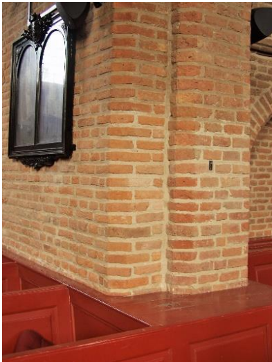
174. Rechts de triomfboog, links de klampmuur. Beide hebben afgeschuinde dagkanten.
