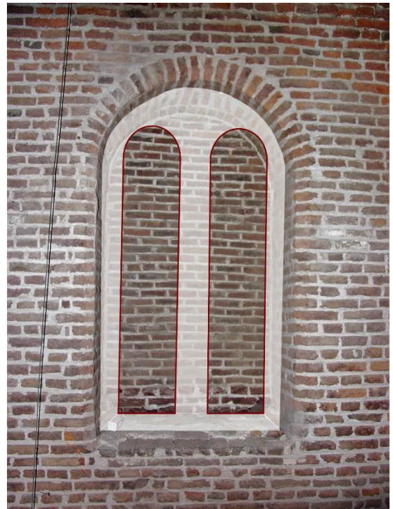
359. Dezelfde rondbogige tweedeling is hier geprojecteerd in het dichtgezette venster aan de oostgevel op de tweede verdieping. Hoogstwaarschijnlijk hebben alle vensters op de tweede verdieping een dergelijke opzet gehad.
