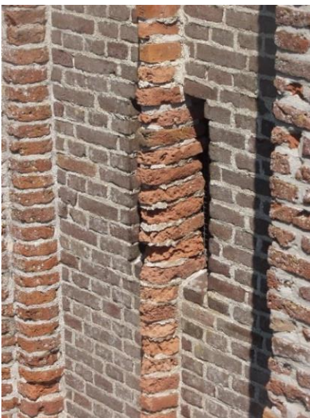
258. Blinde venster tweede geleding westzijde.
