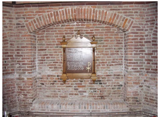
198. De middelste boognis bezit als enige een segmentboog in plaats van een gedrukte korfboog.
