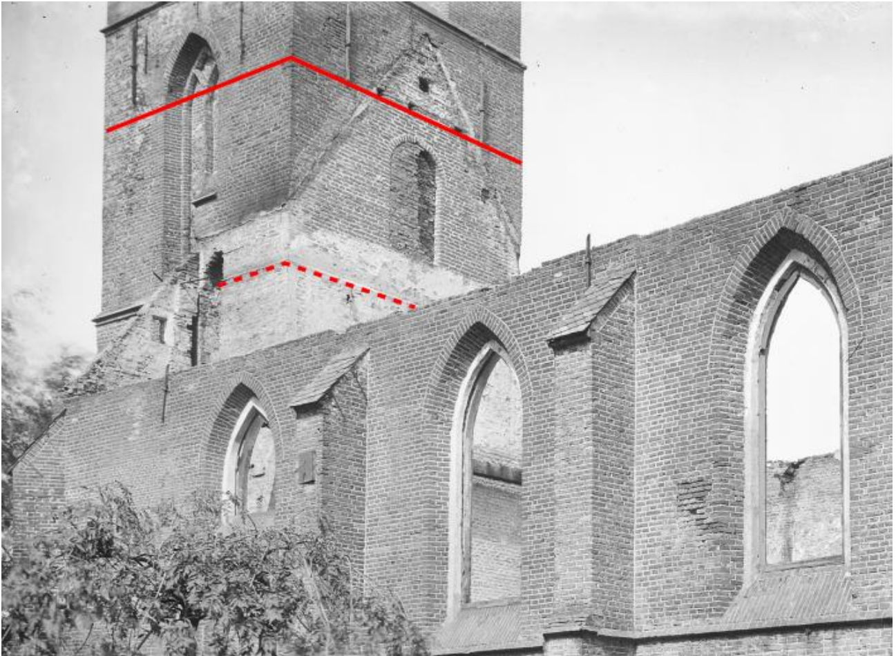
346. Ononderbroken lijn: oorspronkelijke hoogte van de toren. In de punt van de dakaftekening zijn drie kortellingaten te zien waar de steiger voor de verhoging werd opgelegd. De toren stond aanvankelijk vrij. De stippellijn geeft aan waar de waterlijst liep. Deze werd verwijderd toen het schip tegen de toren werd aangebouwd. Let op het dichtgezette romaanse galmgat.
