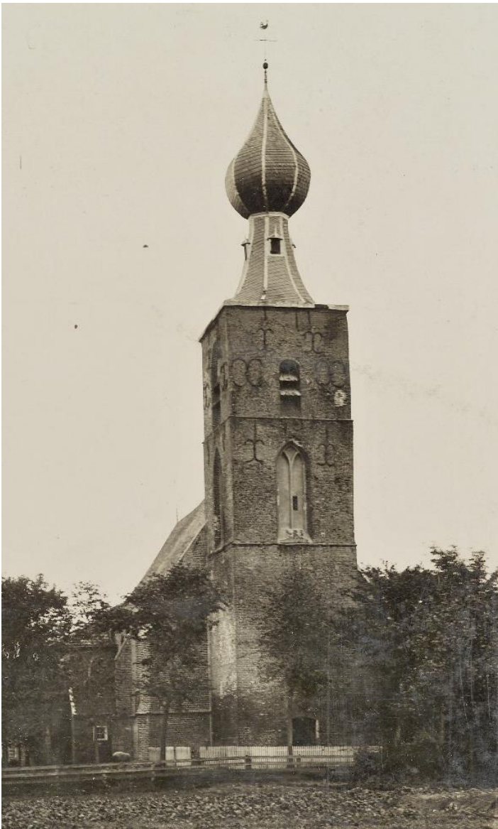
28. Foto uit 1889 (foto RCE). Bovenin het romaanse rondboogvenster, dat in 1891 werd aangepast.
