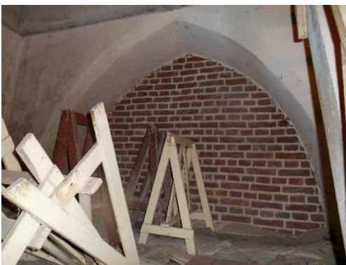
287. De dichtgezette boog vanuit de toren.
