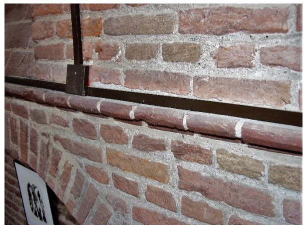
198. De middelste boognis bezit als enige een segmentboog in plaats van een gedrukte korfboog.
