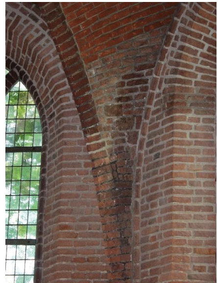
213. De oude gedeelten van het gewelf zijn herkenbaar aan de lichtere steenkleur.
