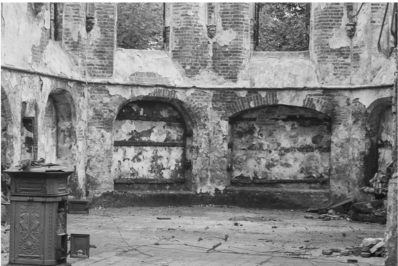
186. Het koor was geheel bepleisterd. In de nissen zijn geblakerde houten regels zichtbaar, ook aan de korte zijden. Het doet vermoeden dat hier een houten wandbeschoot was of dat de nissen zijn gebruikt als banken. Ook in de katholieke periode werden ze gebruikt als zitplaatsen. Links de turfkachel.
