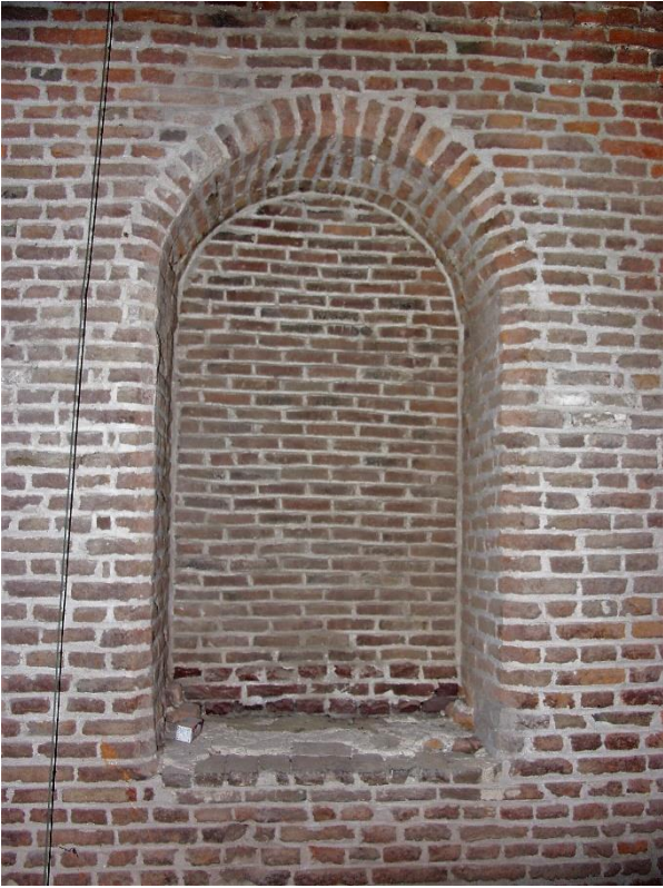
305 - 306. Dichtgezet romaans venster in de oostgevel van de tweede torenverdieping en aan de andere kant, vlak onder het dak. Voor de dichtzetting zijn vormbakstenen gebruikt van 21,5 x 10 x 5,5 cm.
