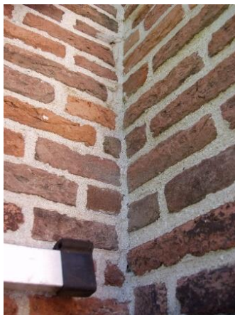
87 - 88. Er is ook een flink verschil in de tienlagenmaat: 63 cm bij de steunbeer van het schip, 72 cm bij die van het koor.
