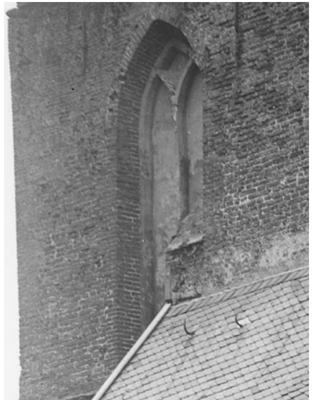
261 - 262. Tweede geleding zuidgevel. De vlakken van het blinde venster waren in 1889 nog gestuukt. Let op de resten van pleisterwerk onder de afzaat
