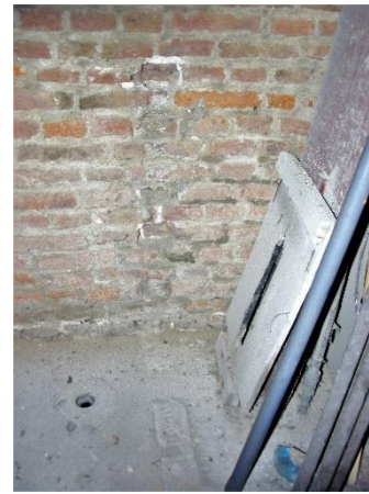
295 - 296. Haksporen van onduidelijke hoekmuurtjes. De aftekeningen staan ook op het beton. Wat het ook geweest is, het dateerde dus van na 1924.
