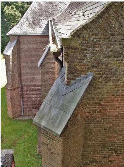
123. Afzaat steunbeer met loodbekleding.
