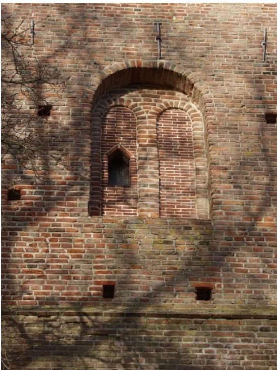
358. Bij de toren te Kolderveen werden de romaanse 'gekoppelde galmgaten' bij een restauratie in 1972/74 opnieuw zichtbaar gemaakt. Ze zijn tweedelig en voorzien van rondboogjes en een gemetselde stijl.
