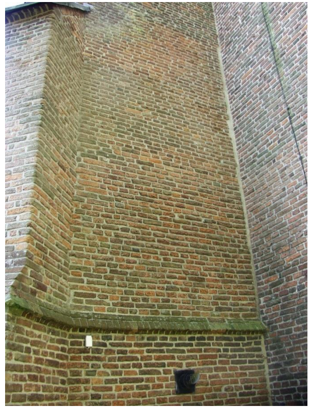
122. De westgevel van het koor is koud tegen de toren geplaatst.
