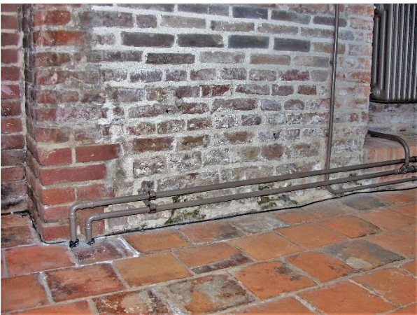
190 - 195. De onderste lagen metselwerk van het koor en triomfboog bestaan uit kloostermoppen met formaten van ca. 30/32 x 14/15 x 7/8,5 cm. De nissen zijn opgehoogd met kleinere stenen.
