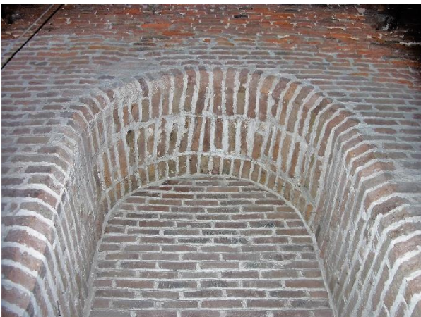
308. De metselwijze van de boog, wijst op een gemetseld raamwerk zoals op pag. XX.
