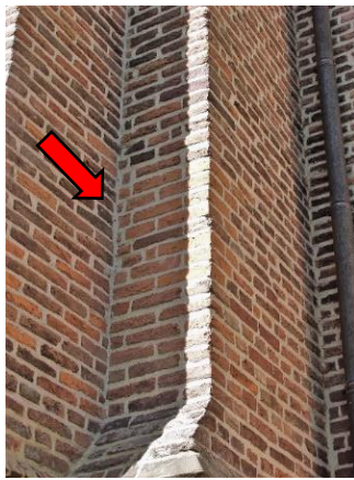
85 - 86. De steunbeer van het schip is duidelijk 'koud' tegen de steunbeer van het koor aangezet.
