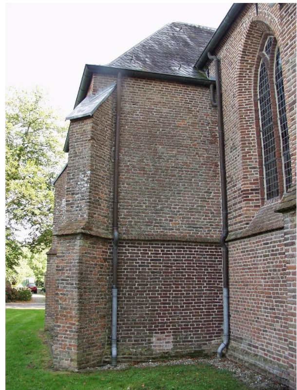
116. Het portaalje is weg. Elk spoor van de toegang is weggewist met de donkere restauratiestenen uit 1924/25.
