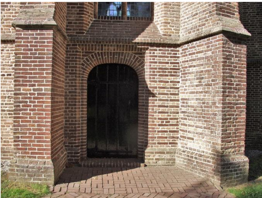
94. Bijna al het metselwerk rond de entree is uit de restauratietijd, ook de 'speklagen' van lichte originele- en donkere restauratiebakstenen.
