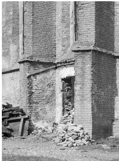
91 - 93. De koorentree voor en na de brand, en tegenwoordig. De rechter steunbeer was hersteld in een kleinere baksteen. Daar is nu niets meer van te zien.
