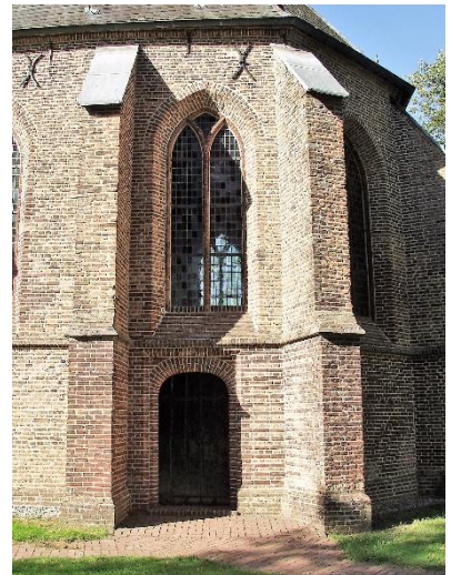
91 - 93. De koorentree voor en na de brand, en tegenwoordig. De rechter steunbeer was hersteld in een kleinere baksteen. Daar is nu niets meer van te zien.
