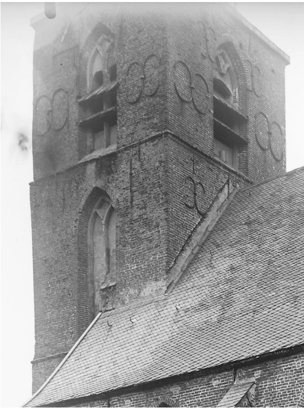
274 - 275. Er zijn heel wat muurankers verdwenen sinds 1889. Let op de gestuukte aftekening van de hogere daklijn van voor 1630; een van de vele bouwsporen die bij de restauratie van 1924/25 werden weggepoetst. Ook werden de blinde vensters en muurvlakken in de galmgaten ontdaan van hun pleisterlaag.
