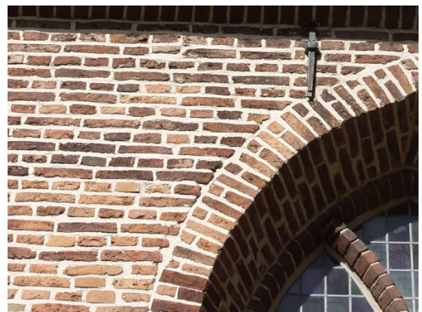
71. Bovenin de gevel zijn de steenformaten veel gelijkmatiger. Er zijn wel afzonderlijke koppen- en strekkenlagen. Het metselverband houdt op diverse plaatsen het midden tussen staand verband en kruisverband. De strekkenlagen verspringen niet met een halve steen ten opzichte van elkaar, zoals bij kruisverband, maar met een kwartsteen.
