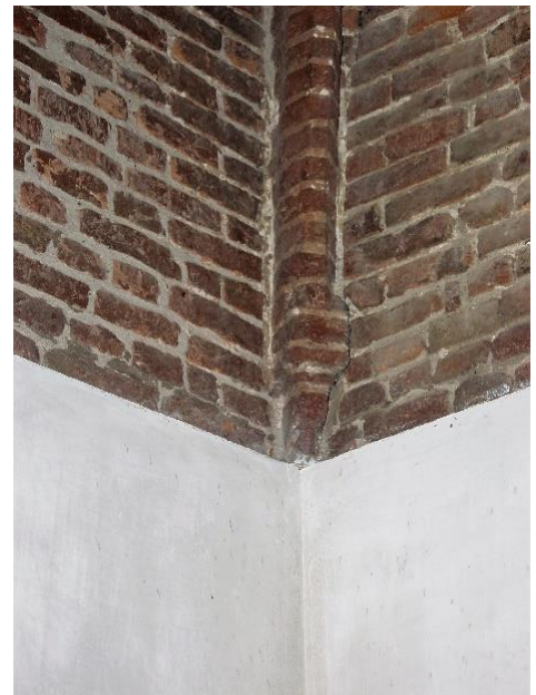
181. Geprofileerde bakstenen gewelfaanzet.
