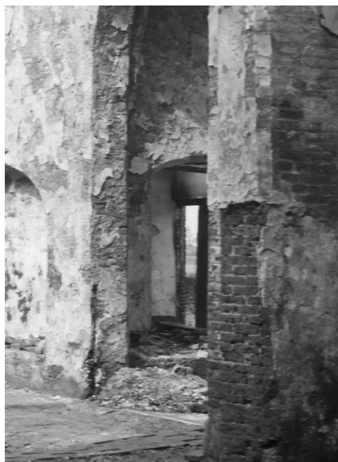
182 – 183. In de boognis bevond zich een deurvenster naar het voorportaalje.
