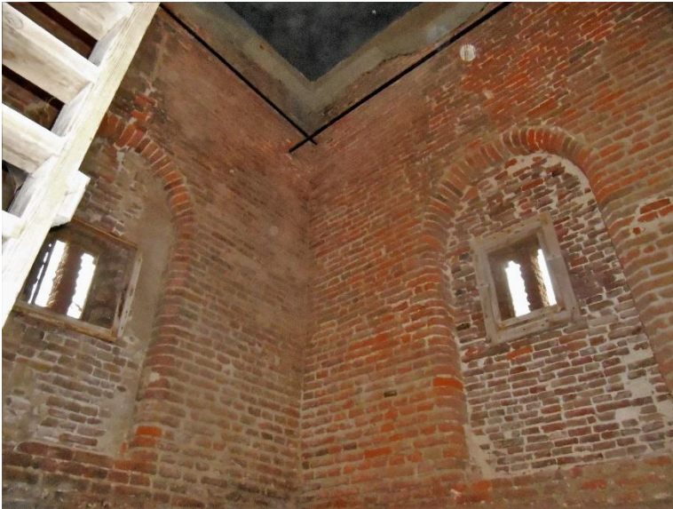
301 - 302. De ogenschijnlijk volbloed-gotische vensters in de buitengevel, blijken binnen op de tweede verdieping romaanse rondbogen te bevatten. De vensters zijn slordig dichtgezet. Daarbinnen zijn kleine tweedelige vensters aangebracht rond montant van de blindvensters.
