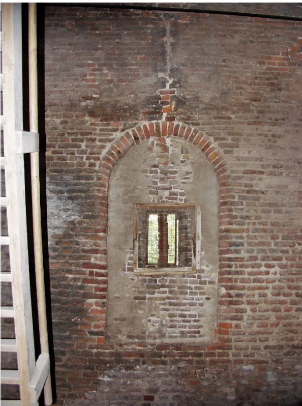
303. Het westelijke venster, dichtgezet met stenen van 22,5 x 10,5 x 5,5 cm.
