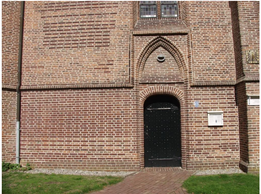
58. Het uitwendige metselwerk onder de waterlijst van de eerste travee is na 1923 vrijwel geheel vernieuwd.
