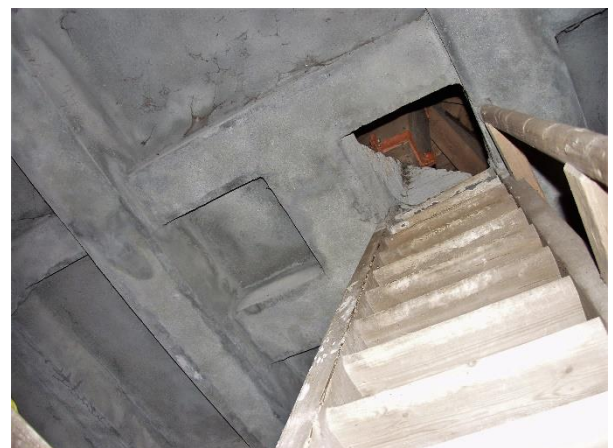
317. Betonnen vloer van de torenspits, gezien vanaf de derde verdieping.
