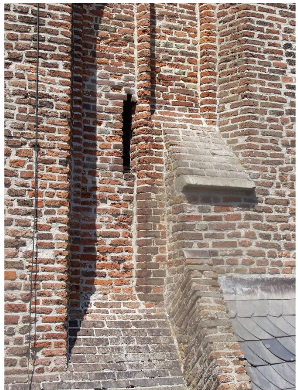
264. De afzaat in de nis markeert de plek van de vroegere muurtrap. Het dat van voor 1630 sloot er vlak onder aan.
