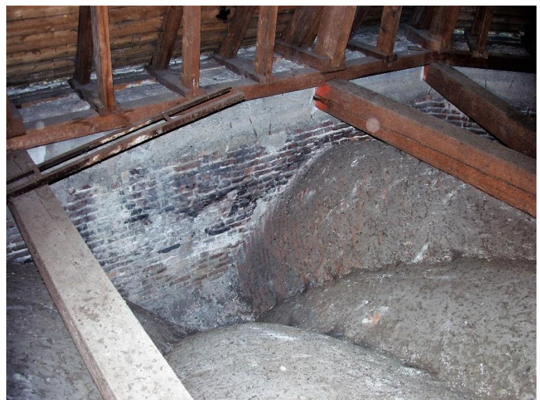
233. Boven de koorgewelven zijn nog de geblakerde muren te zien.
