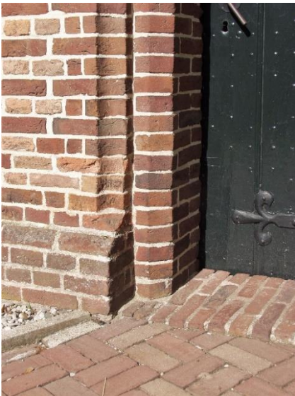
63. Metselwerk vernieuwd na 1923.
