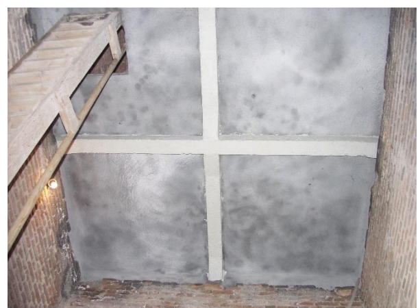
300. Betonnen verdiepingvloer gezien vanaf de eerste verdieping.
