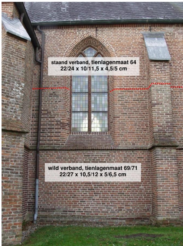
117. Een duidelijke fasegrens. Deze formaten zijn ook representatief voor het laatste travee.
