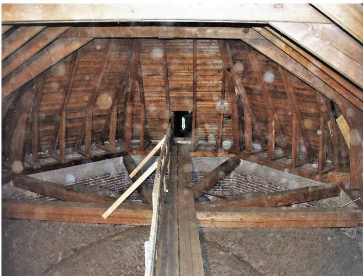
230. Constructie boven de koorsluiting
