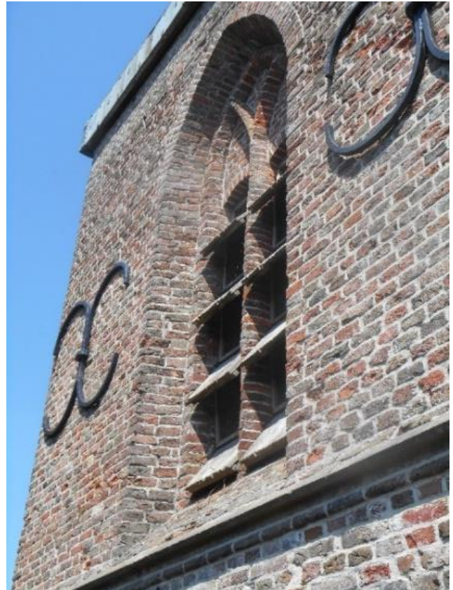
260. Dit 'gotische' galmgat kwam pas in 1891 in de plaats van een romaans venster.
