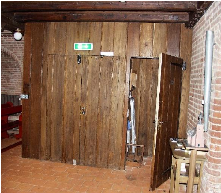
152. Beschotwand entreeruimte en trapopgang/toilet.
