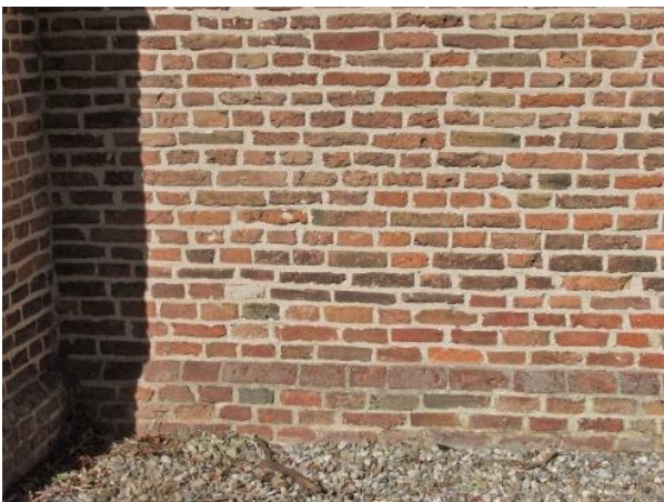
70. In het onderste deel van het schip vertonen de steenformaten grote verschillen. Het metselverband is wild verband, zonder afzonderlijke koppen- en strekkenlagen.
