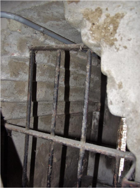
290. Getrapt venster begane grond zuidzijde.
