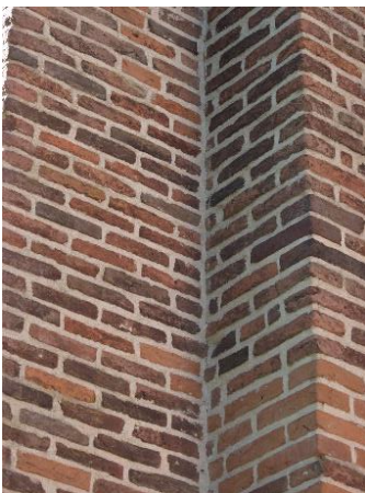
87 - 88. Er is ook een flink verschil in de tienlagenmaat: 63 cm bij de steunbeer van het schip, 72 cm bij die van het koor.
