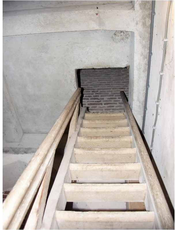
291. Houten laddertrap naar eerste verdieping.
