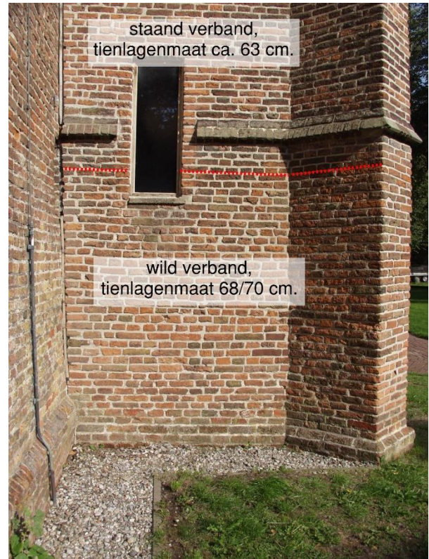
55. Tot even onder de waterlijst is gemetseld in wild verband, daarboven in staand verband met een kleiner steenformaat.
