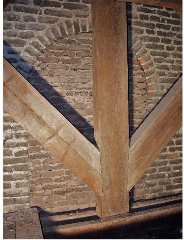
305 - 306. Dichtgezet romaans venster in de oostgevel van de tweede torenverdieping en aan de andere kant, vlak onder het dak. Voor de dichtzetting zijn vormbakstenen gebruikt van 21,5 x 10 x 5,5 cm.
