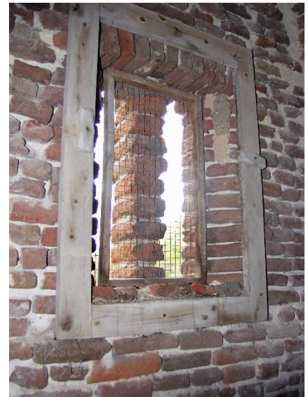
301 - 302. De ogenschijnlijk volbloed-gotische vensters in de buitengevel, blijken binnen op de tweede verdieping romaanse rondbogen te bevatten. De vensters zijn slordig dichtgezet. Daarbinnen zijn kleine tweedelige vensters aangebracht rond montant van de blindvensters.
